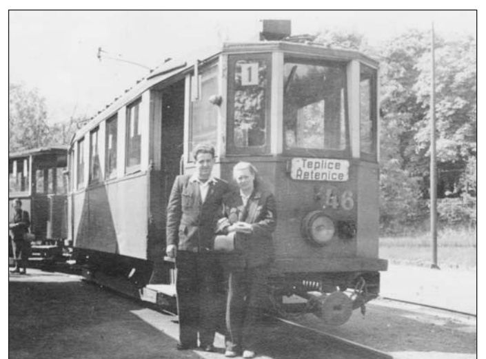
K pamětníkům staré gardy tramvajáků v Teplicích patřil pan Jiří Vopravil, který nastoupil jako řidič tramvaje roku 1947. Na snímku je s průvodčí tramvaje na konečné lince č. 1 v horním Dubí.
